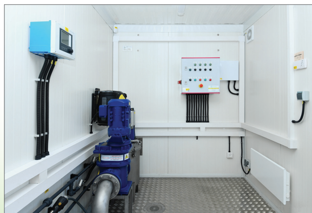
2 pav. SewaLux nuotekų priėmimo mazgo įranga.
