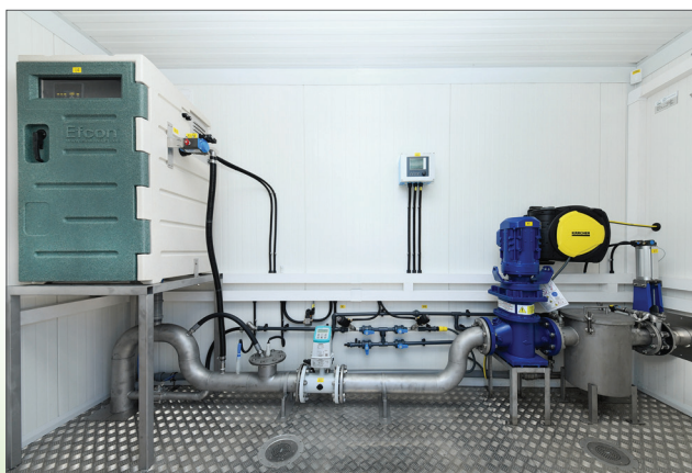
2 pav. SewaLux nuotekų priėmimo mazgo įranga.
