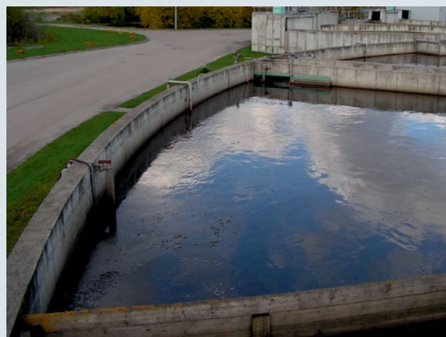
6 pav. Miesto nuotekų valymo įrenginiai prieš ir GREASOLUX naudojimo metu: po kelių mėnesių naudojimo visiškai pašalino aerotanką dengęs riebalų sluoksnis
