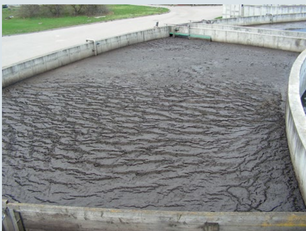
6 pav. Miesto nuotekų valymo įrenginiai prieš ir GREASOLUX naudojimo metu: po kelių mėnesių naudojimo visiškai pašalino aerotanką dengęs riebalų sluoksnis
